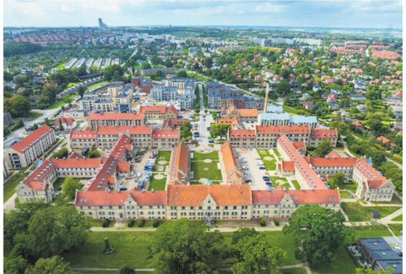
Det tidligere psykiatriske hospital imiterer hollandsk renaissancestil og er bygget i 1852. Det hele er fredet på nær en mindre del som har højeste bevaringsværdi. Alligevel er det lykkedes at omdanne bygningerne til boliger, og det arbejde er nu nomineret til Renoverprisen. Foto: Jens Thaysen
