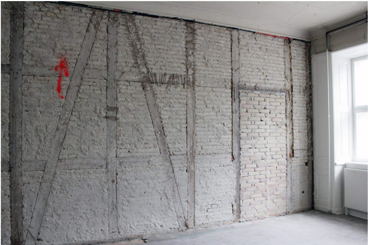
I den ældste del af bebyggelsen dukker der bindingsværk op, når vægbeklædningen er fjernet.
