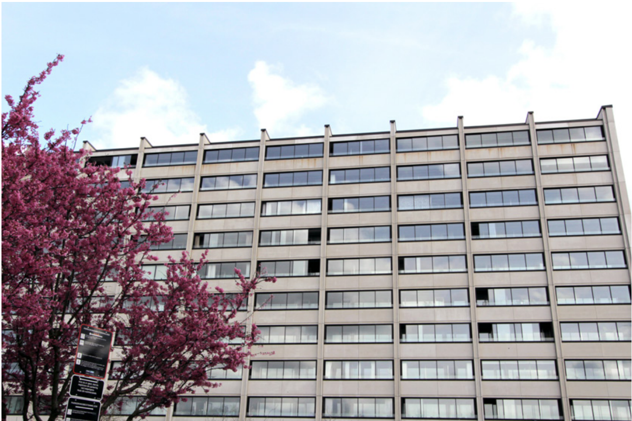
Nye facader i afd. 25 - Klostervangen
